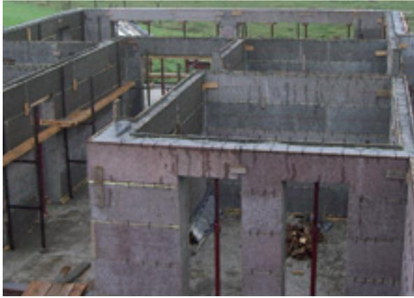
Avant de placer la dalle, il convient une nouvelle fois de vérifier les axes des murs et de les redresser en cas de besoin. En fonction du plan et de la disposition des éléments de la dalle, placer des étais de maçon et des madriers porteurs, qu'il convient de clouer au panneau intérieur du coffrage.
