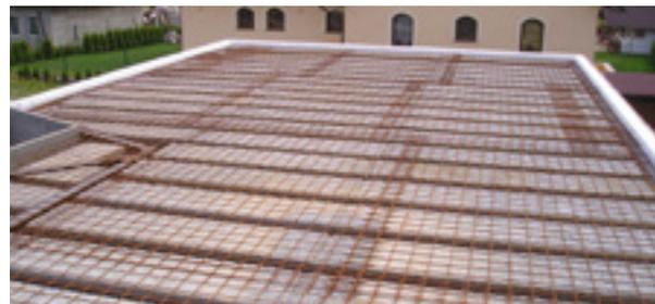
Les éléments de la dalle préfabriquée se placent sur les champs des panneaux intérieurs des murs et sur les madriers porteurs. Ils sont cloués aux panneaux intérieurs des murs, sur tout le pourtour de la pièce.
