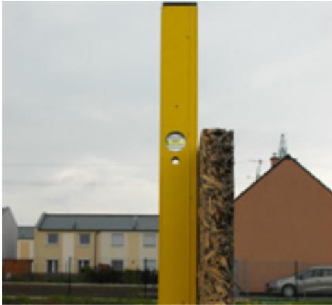
Après avoir terminé l'assemblage du premier rang de coffrage des murs, continuer en bétonnant l'intégralité du plan du bâtiment, jusqu'à une hauteur +/- 400 mm, soit jusqu'au bord inférieur des doubles entretoises. La compression du béton s'effectue par damage.
