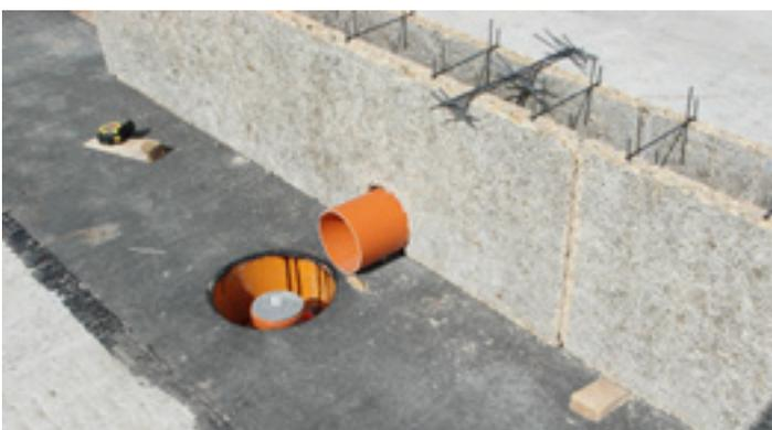
Lors de l'assemblage du premier rang des panneaux de coffrage, il convient de réaliser simultanément le coffrage des murs porteurs intérieurs et des cloisons.
