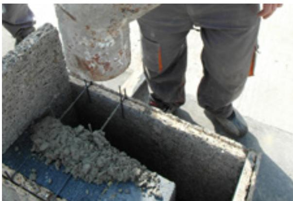
Une fois le panneau intérieur placé en bas dans les entretoises de base, on place les entretoises doubles de raccordement en haut des panneaux.
