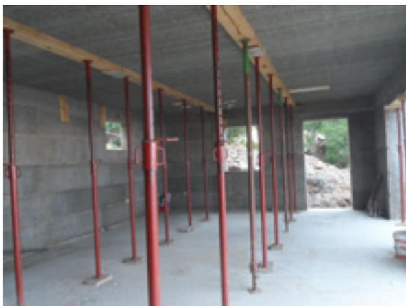
Le mélange de béton est ensuite progressivement coulé dans les coffrages des murs et des dalles préalablement assemblés. Cette opération concerne également le bétonnage final d'une chape de béton de 50 mm, au-dessus des éléments de la dalle préfabriquée. L'assemblage du coffrage des murs peut ensuite reprendre, au-dessus du sol que l'on vient ainsi de réaliser.
