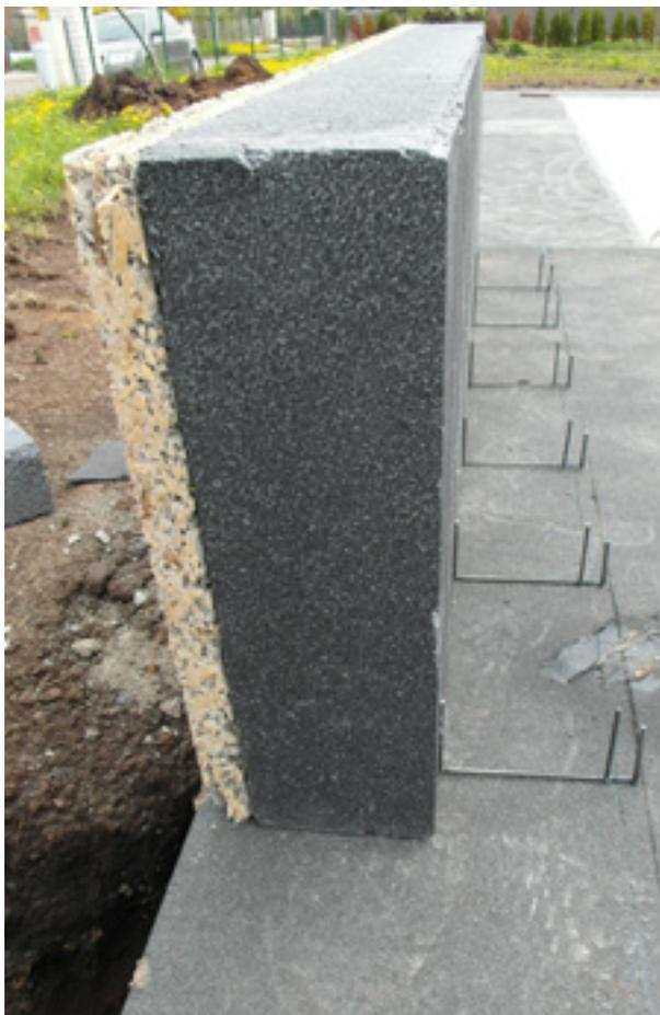
Le panneau isolé extérieur du mur formant l'angle se place ensuite en bas, dans les entretoises, puis se bloque en haut par les entretoises doubles de raccordement (8 entretoises pour 2m de panneau). Après avoir aligné l'angle, le panneau se fixe à l'aide de clous, comme le panneau intérieur.
