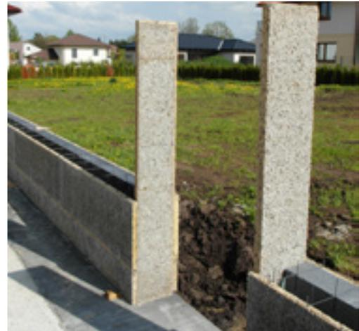
Durant l'assemblage, il est possible d'intégrer des installations dans le coffrage ou, les petites rainures de l'installation électrique peuvent être fraisées, le plus souvent appliquées.
